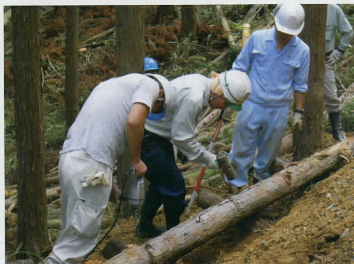
作業道を開設する際に法面の勾配を安定させるため、丸太組を行います。
