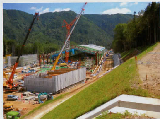
工事棟建設状況(H22.9)
