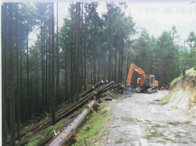
搬出する材木を作業道脇まで全幹で引き出します。
